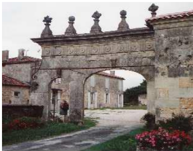
Portail du Logis de La Motte
